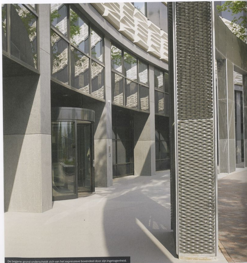
De begane grond onderscheidt zich van het expressieve bovendeel door zijn ingetogenheid.
